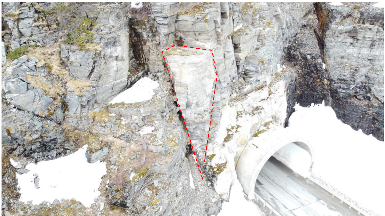
Foto 4 Viser blokk over portal i nord på omtrent 20 m 3 . Foten av blokka er mer oppknust enn resten av bergmassen, og det anbefales sikring av blokken. Detaljprosjektering av sikring må utføres etter rensk av ingeniørgeolog.
