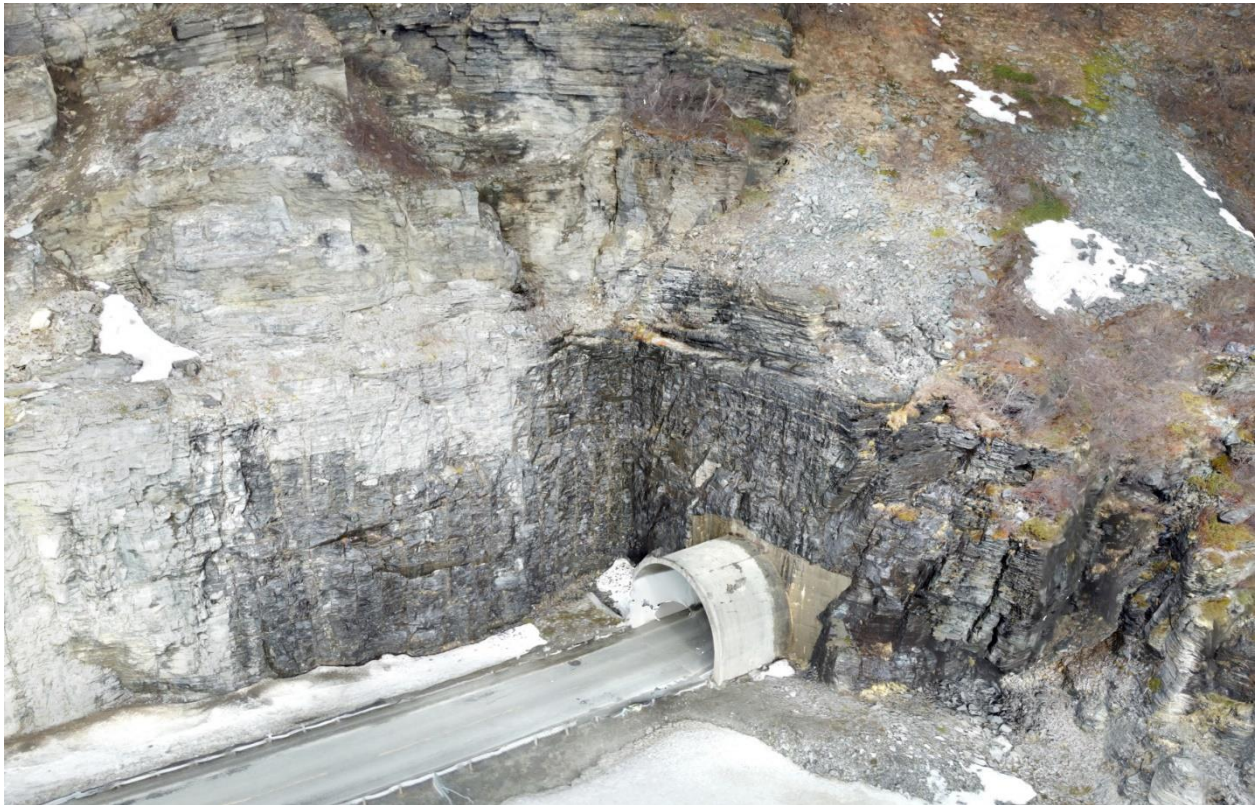
Foto 1 Oversiktsbilde av påhugg og forskjæring ved Sortviktunnelen sør.
